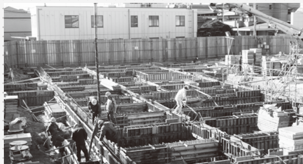
基礎工事がすすむ現場
